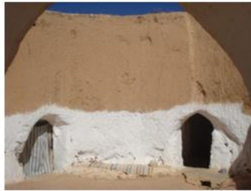
La chaux est utilisée pour donner la couleur Blanche lumineuse aux pièces d'habitation et pour différencier l'espace creusé de la roche montagneuse. Source: Auteur
