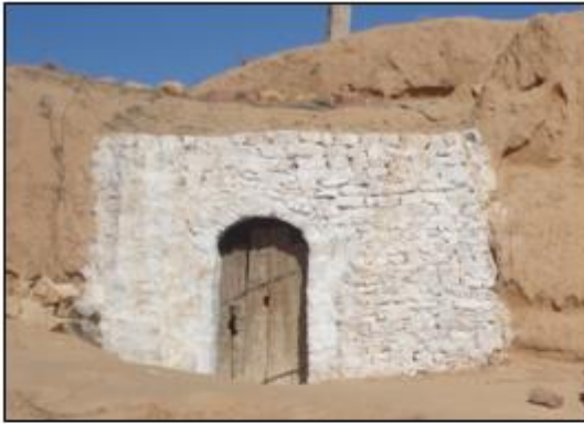
Utilisation de la pierre pour le soutènement des parois argileuses. Source: Auteur
